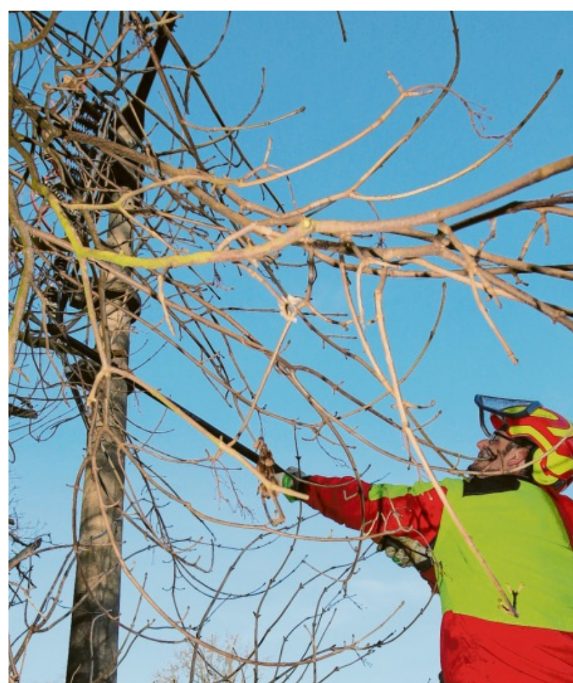
Mit Motorsäge und Astschere werden derzeit Bäume und Sträucher entlang der Stromleitungen im LVN-Netzgebiet zurückgeschnitten, um Stromausfällen vorzubeugen. Foto: Michael Hochgemuth/LEW
